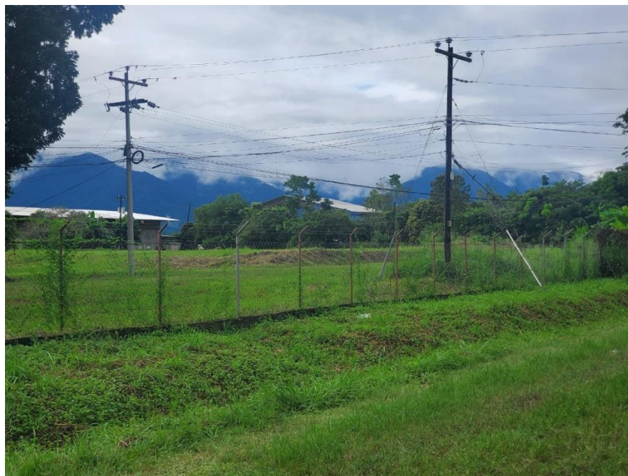
Anexo 06 – Área para construir rampa sobre canal de drenaje y sistema eléctrico a reubicar.
