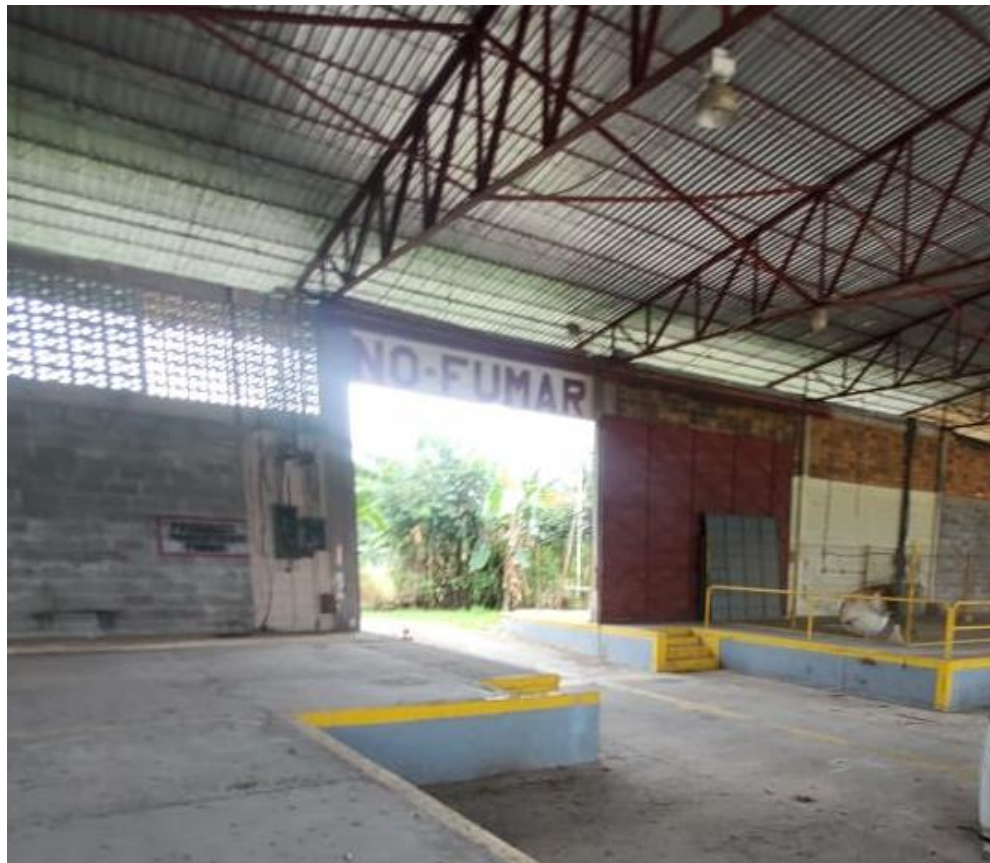
Anexo 04 - Reparación de portón principal de acceso.
